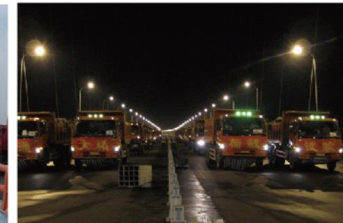
苏通大桥成桥荷载试验
