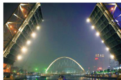
开启桥修复 - 天津解放桥
