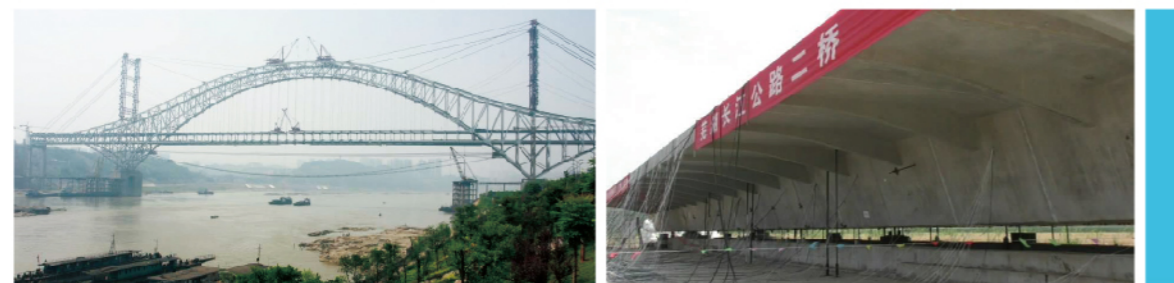
朝天门大桥施工过程仿真分析(主跨552米钢桁架拱桥)
