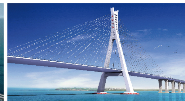
海南铺前大桥健康监测系统
