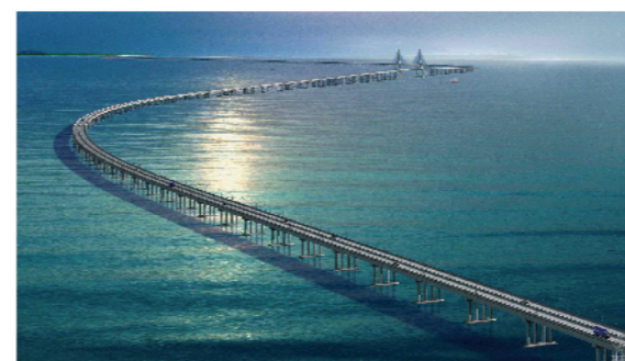
东海大桥健康监测系统
