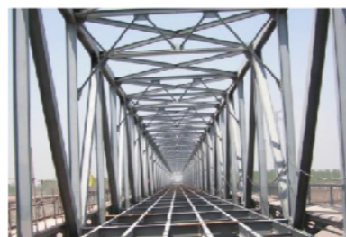
钢桁架桥评定与加固 - 北镇黄河大桥等十余座
