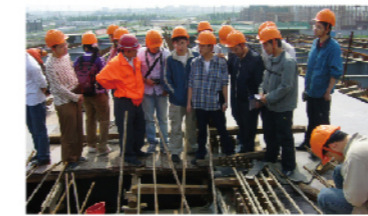
常州运河桥梁工地毕业实习
