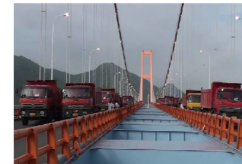
西埃门大桥成桥荷载试验
