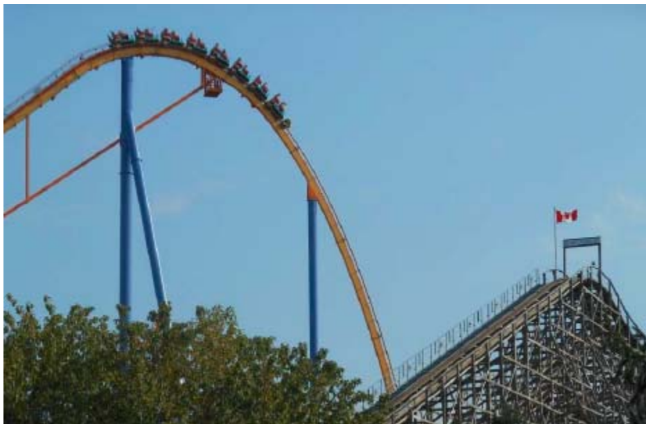
钢支撑轨道 (左)，木结构支撑 (右)
